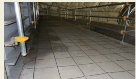
上部モルタル低拡散材でのひずみ計測
