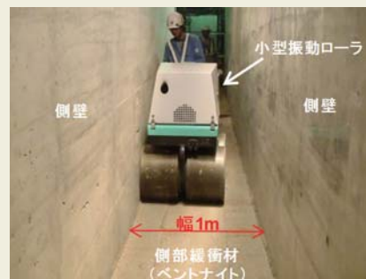
ベントナイト緩衝材の側部狭隘部の施工試験
