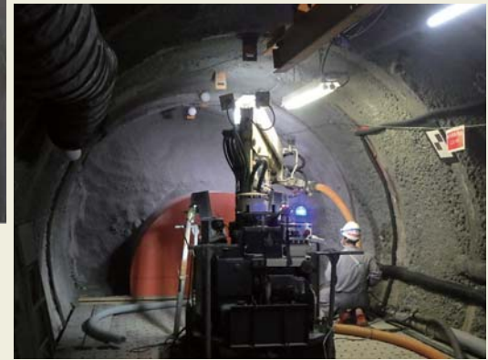
埋め戻し材の吹付試験
