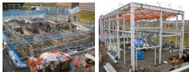
型枠組立状況
