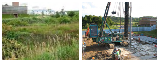
工事着手前全景
