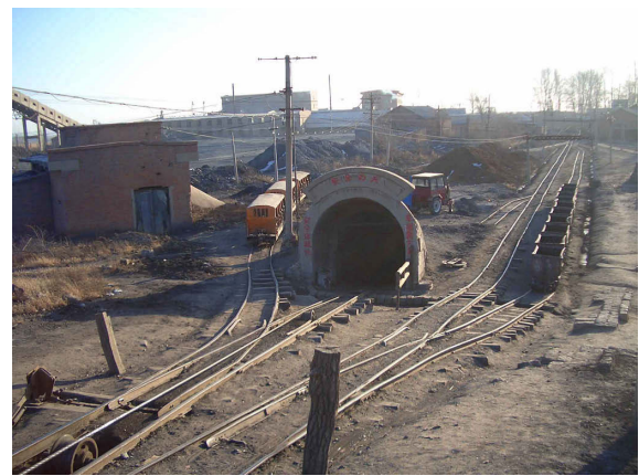
写真-3 四平劉房子磁業の坑口
