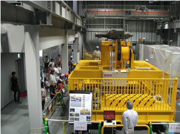
緩衝材定置試験設備全景
