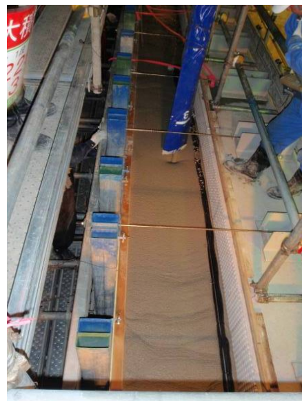
図-15 低拡散材（側部）の打込み状況
