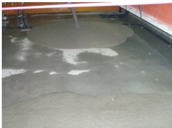
図-16 低拡散材（上部）の打込み状況
