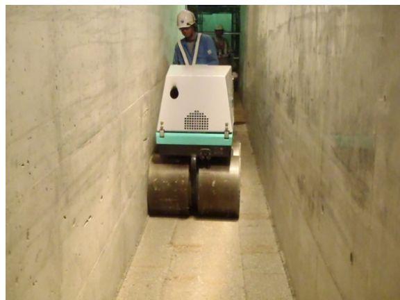
図-8 小型振動ローラによる施工状況（側部）
