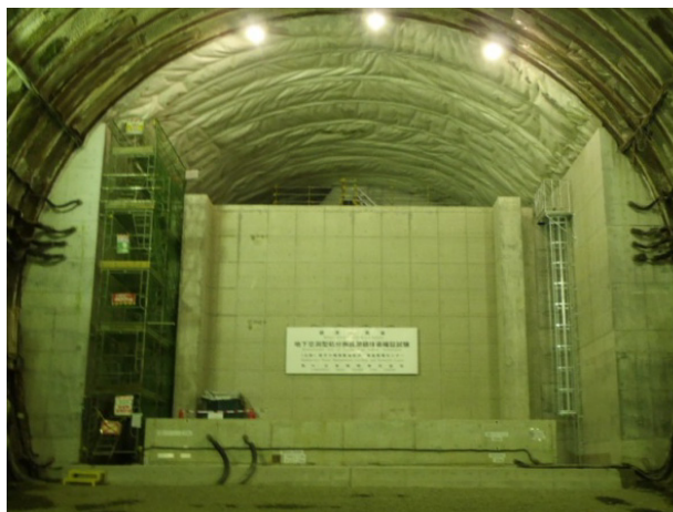
図-5 試験施設の状況（平成27年3月）
