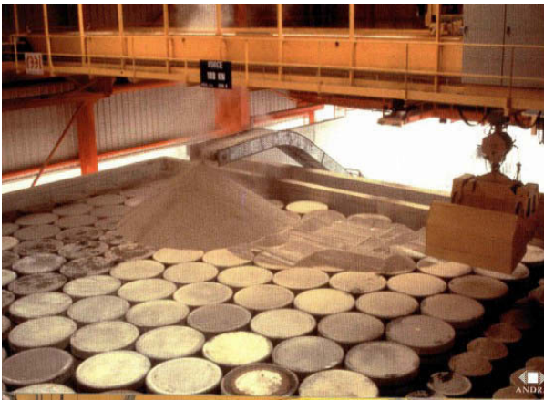
写真-2 ロープ処分場における廃棄体定置状況
