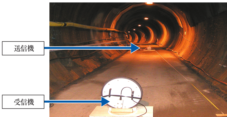
図2.4 試験状況（Äspö島のHRL、地下460mレベル）
