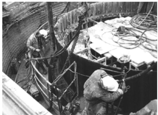
主立坑の建設状況（コンクリート打設中）
