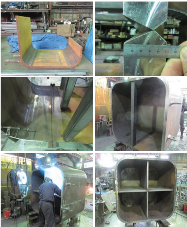
図-4 容器本体の製作状況
