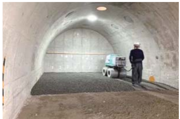
坑道の埋め戻し施工試験の実施状況
