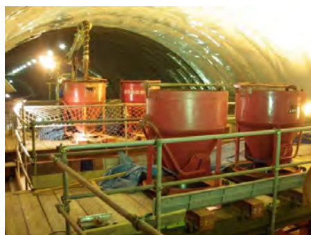
図 2.4-11 バケット打込み状況
