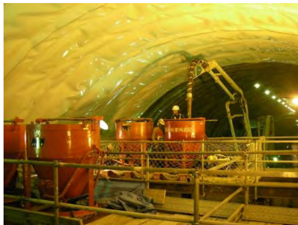
図 2.4-3 上部充てん材施工状況
