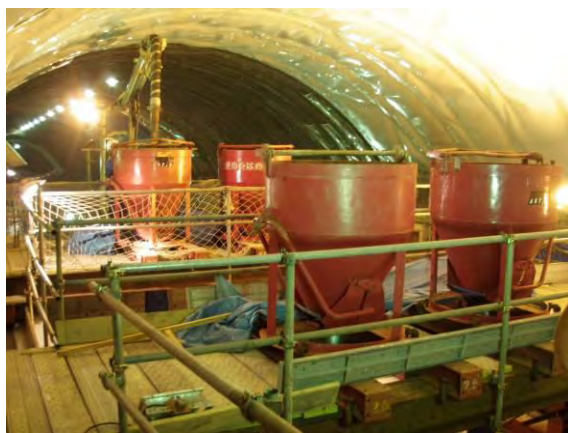
図 2.4-14 バケット配置状況
