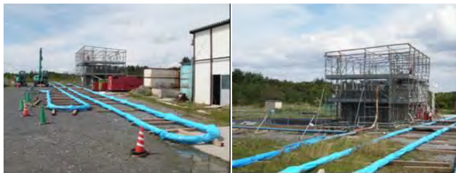
図 2.4-4 長距離圧送試験の試験状況
