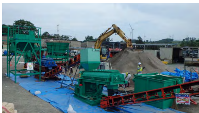
図 2.5-4 混合土製造状況
