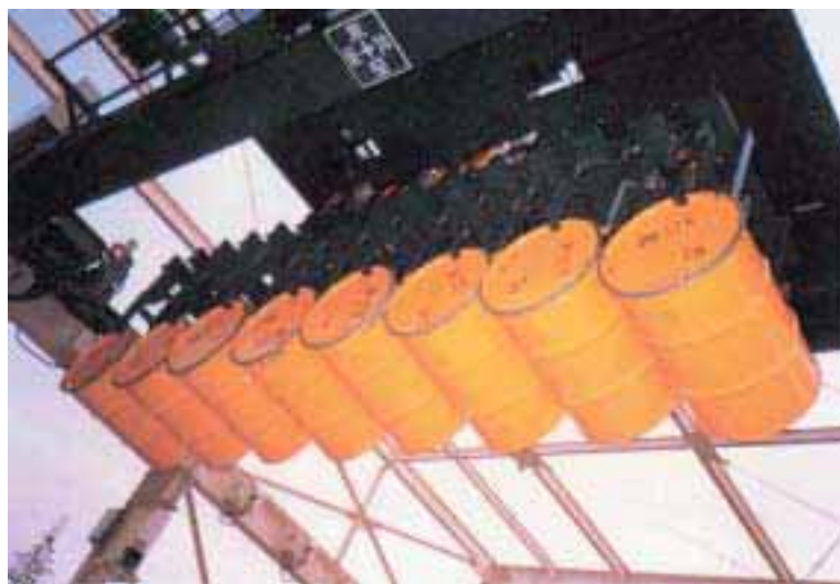
埋設施設へ廃棄体 8 本を一括定置するための 試作クレーンによる模擬廃棄体吊り上げ状況
