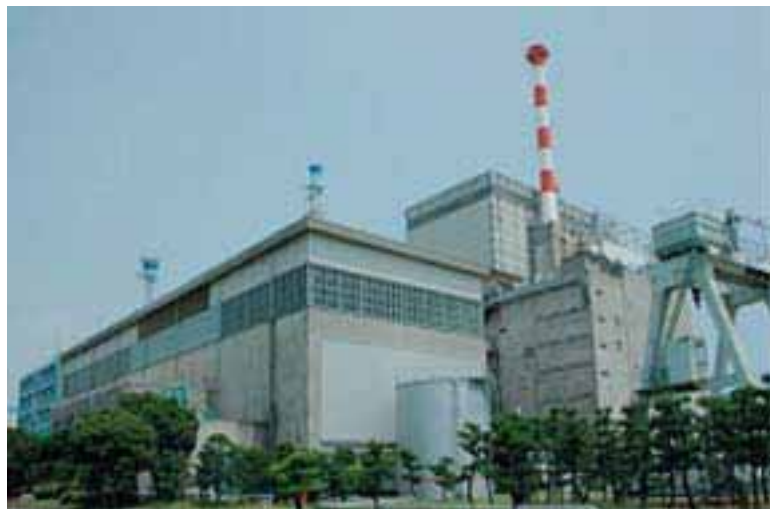
日本原子力発電株式会社東海発電所 （同社ホームページ）
