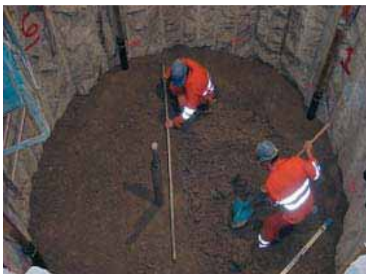
底部ベントナイト系緩衝材の施工
