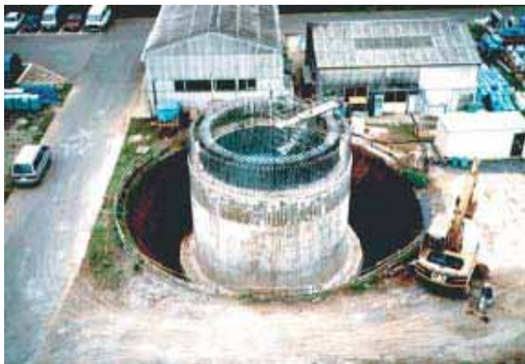
コンクリートサイロ試験設備の建設
