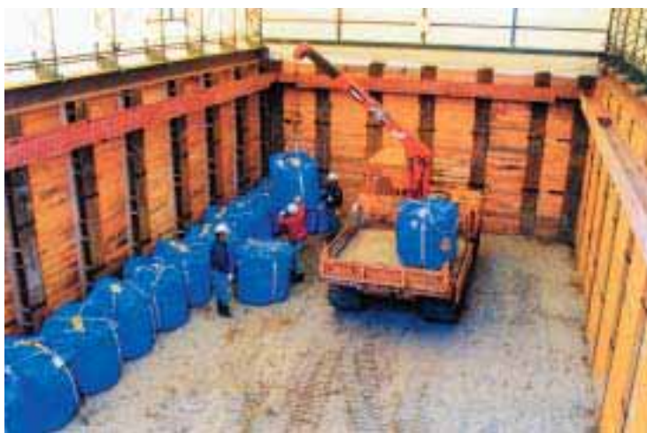
日本原子力研究所トレンチ内への廃棄物定置状況
