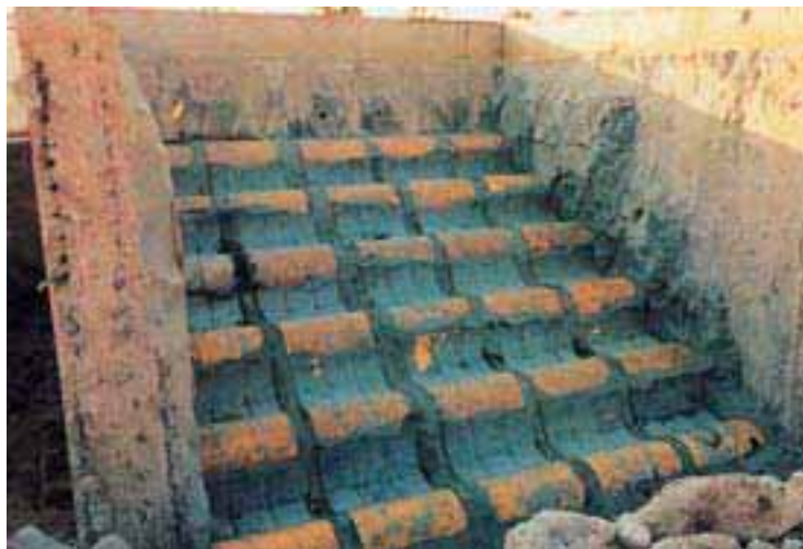
模擬埋設設備の解体状況 (充填材が隅々まで充填されている。)
