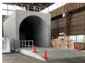
図-3 模擬坑道の外観
