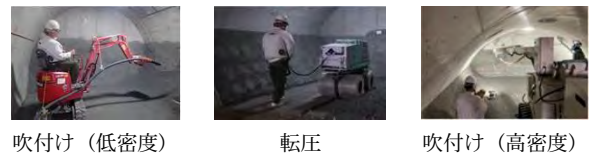
図-5 転圧工法及び吹付け工法の施工試験状況
