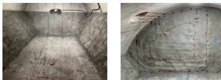
(a) 転圧施工部分 (b) 吹付け施工部分 図-8 加熱式光ファイバの設置状況
