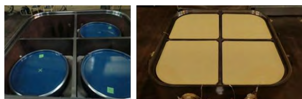
図-3 廃棄体及び断熱材の設置状態
