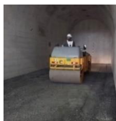
(a) 模擬坑道の外観 (b) タンデムローラーの転圧状況
