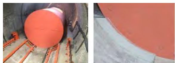
図-4 隙間充填装置（左）、充填後の下部狭隘部（右）
