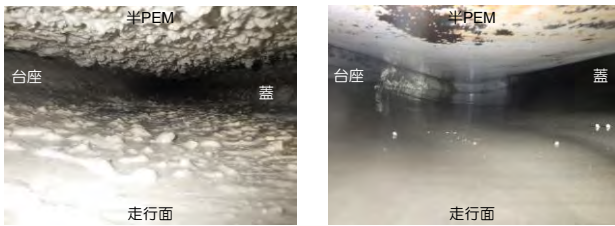
トルネードノズルによる除去後 配管清掃用ノズルによる除去後 図-9 流体的除去技術による下部狭隘部の除去の様子
