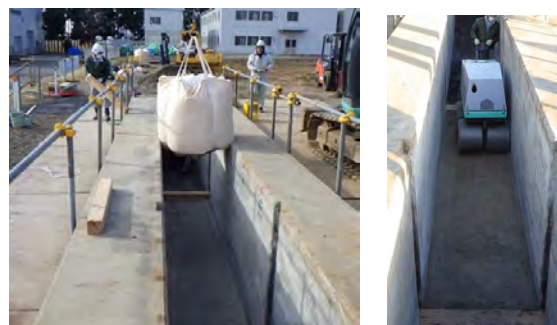
図-6 撒き出し・転圧工法による試験状況
