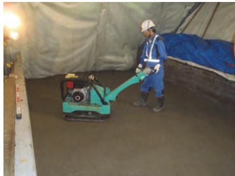
図-8 バイブロコンパクタによる本転圧状況
