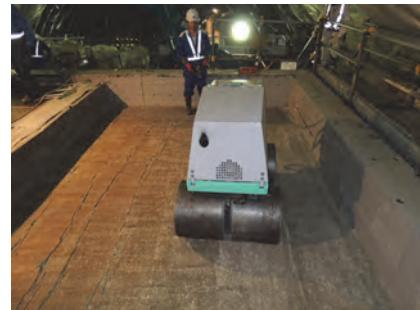
図-3 小型振動ローラによる転圧状況
