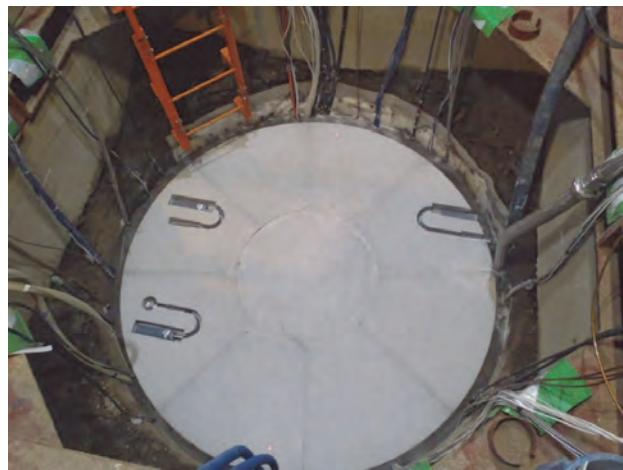
図-2 人工バリア性能確認試験における模擬処分孔中の緩衝材ブロックへの小型地中無線送信装置の設置状況 (左下 : 土圧計、左上及び右上 : 間隙水圧計)
