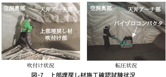
図-7 上部埋戻し材施工確認試験状況
