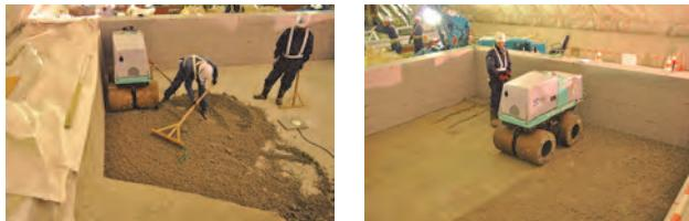
図-4 上部緩衝材平面部施工確認実施状況
