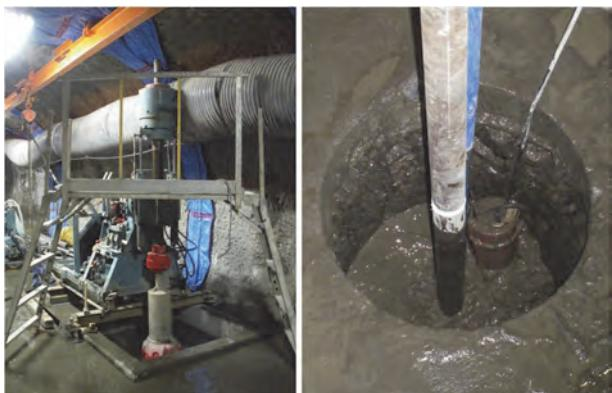
図-6 地下施設での試験孔掘削状況
