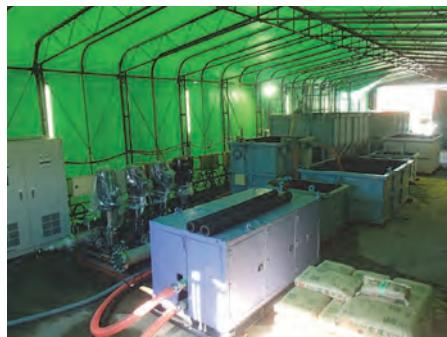
図-5 塩水リユース設備設置状況
