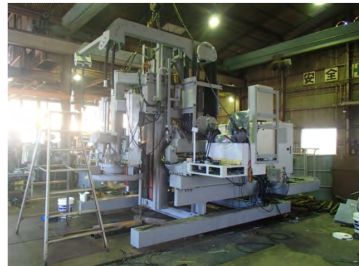
図-7 昇降設備製作状況
