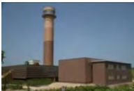
地層処分実規模設備(幌延)
