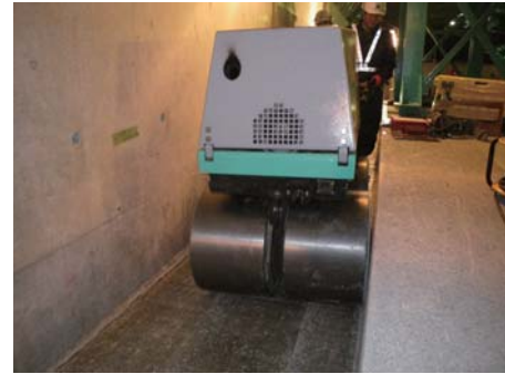
図-3 小型振動ローラによる施工状況
