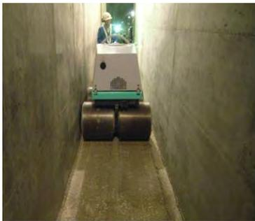
写真-3 小型振動ローラの振動転圧状況
