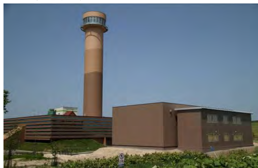
図-1 地層処分実規模試験施設
