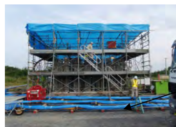
図-6 充填材充填性測定状況
