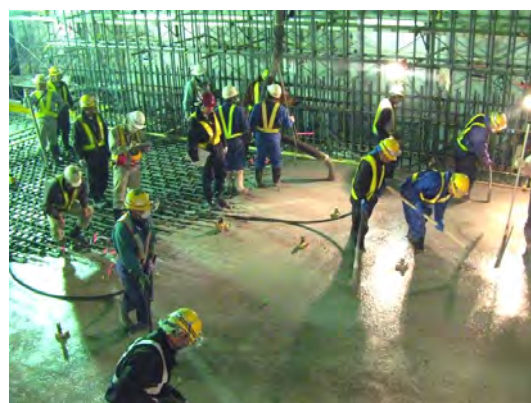
図-6 底部コンクリートピット打設状況
