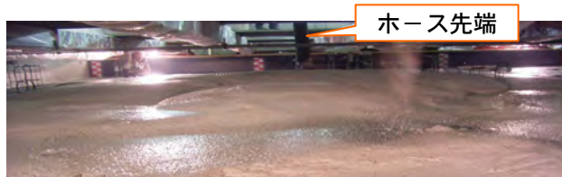
図-5 底部低拡散材モルタル打設状況
