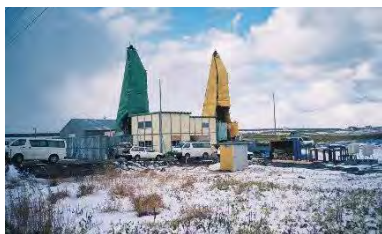
図-1 ボーリング孔掘削地点の外観
