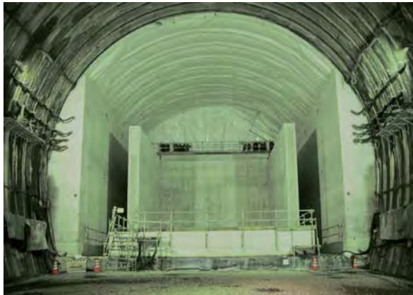
図-7 底部・奥部・側部コンクリートピット施工状況
