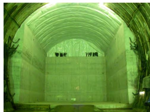
図-4 底部・側部埋戻し材施工確認試験（完成写真）
