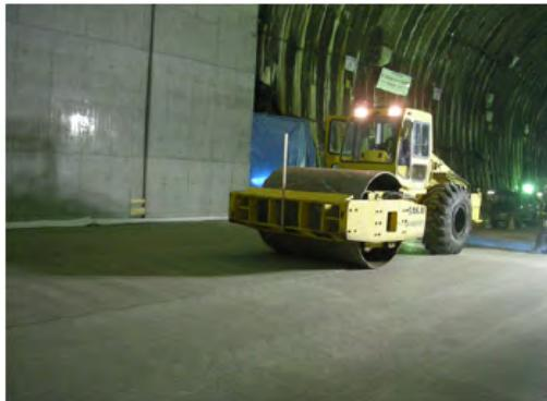
図-5 大型振動ローラによる転圧状況
