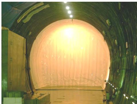
図-2 試験空洞内滴水対策工（完成写真）
