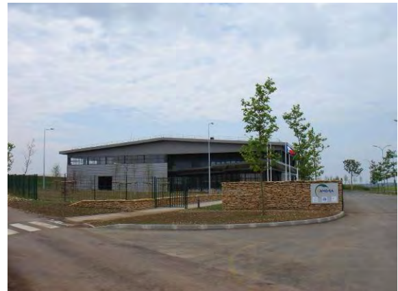
図-7 技術センターの外観
