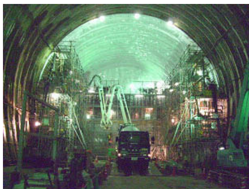
図-5 側部埋戻し材コンクリート打設状況
