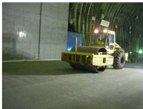
図-7 大型振動ローラーによる底部緩衝材施工
