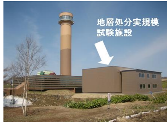
図7 実規模施設の外観
