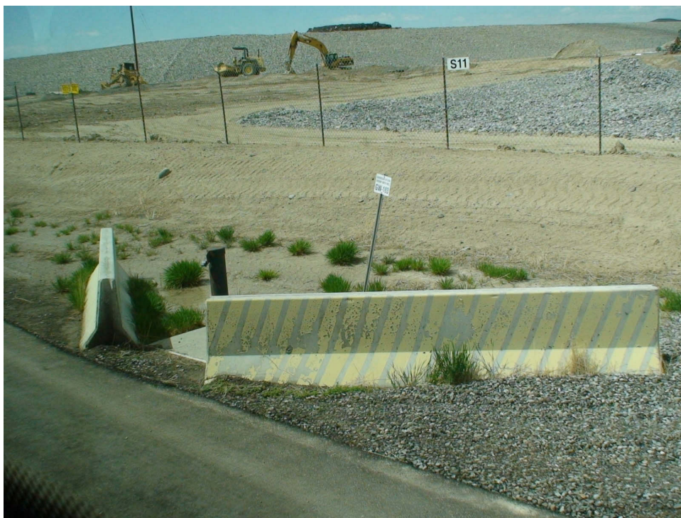
<クライブ処分場の地下水サンプリング井>
