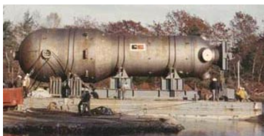
図-3 蒸気発生器のバージ輸送
