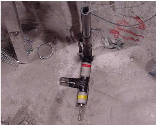
図-9 測定器設置状況（リング状に整形されたベントナイトによる止水対策）
