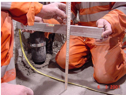
図-6 締固め後の層厚の測定
