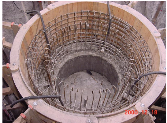
図-3 コンクリートサイロ施工状況
