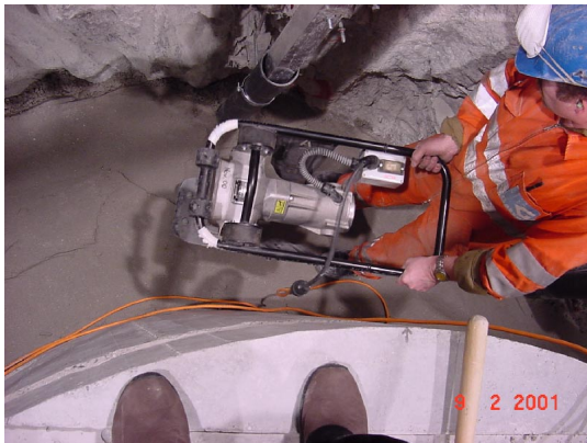
図-5 充てん材締固め状況（側壁）
