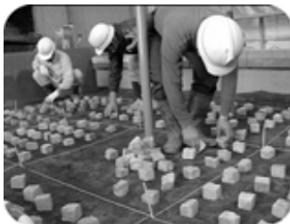
図-6 模擬トレーサ（含浸コンクリート片）埋設状況
